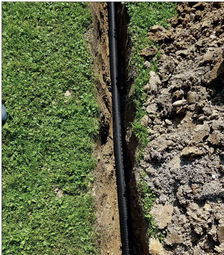
Leerschlauch - 50 mm (vorzugsweise ein PE-Rohr)
